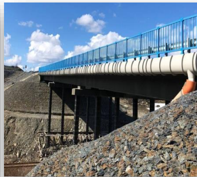
путепровод ЗАПОЛЯРНЫЙ- САЛЬМИЯРВИ
